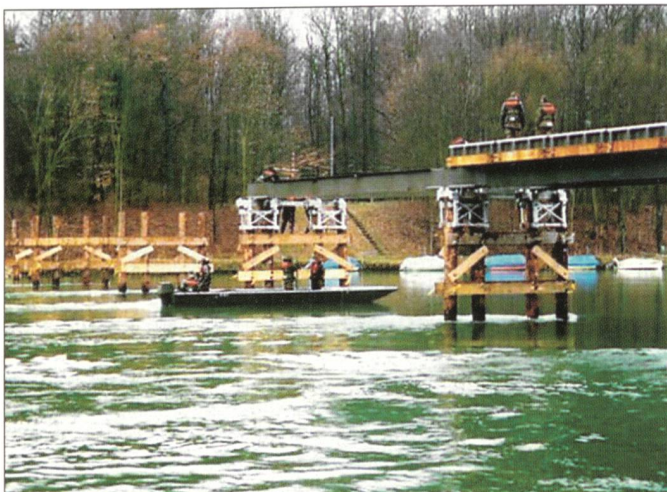
Genietruppen beim Brückenbau.
