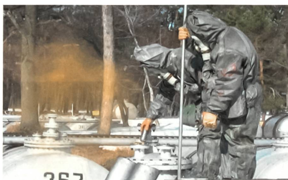
Die Arbeit in der Nähe der Tanks mit Melange ist nur noch in Schutzanzügen möglich.
