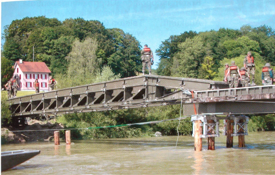
Das Geniebataillon 9 baut eine Brücke über die Thur bei Warth TG.
