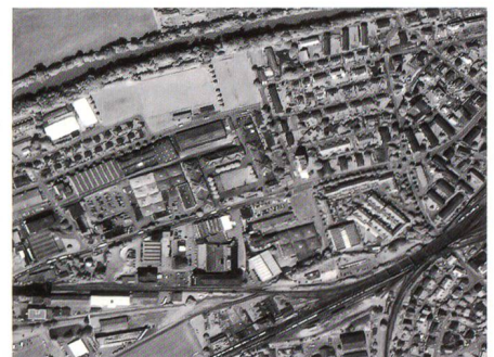
Bild vom Satellit EROS von der Umgebung des Zeughauses Burgdorf.
