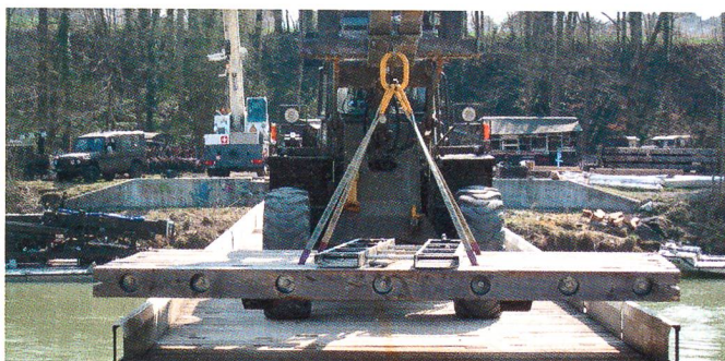
In 19 Stunden baut die Bausappeurkompanie 4/4 eine 71 Meter lange Stahlträgerbrücke über die Thur.
