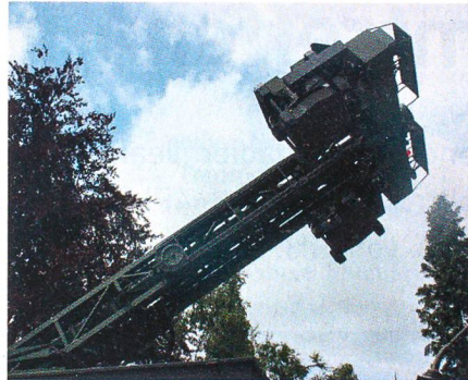
Der mächtige Mast wird aufgerichtet.
