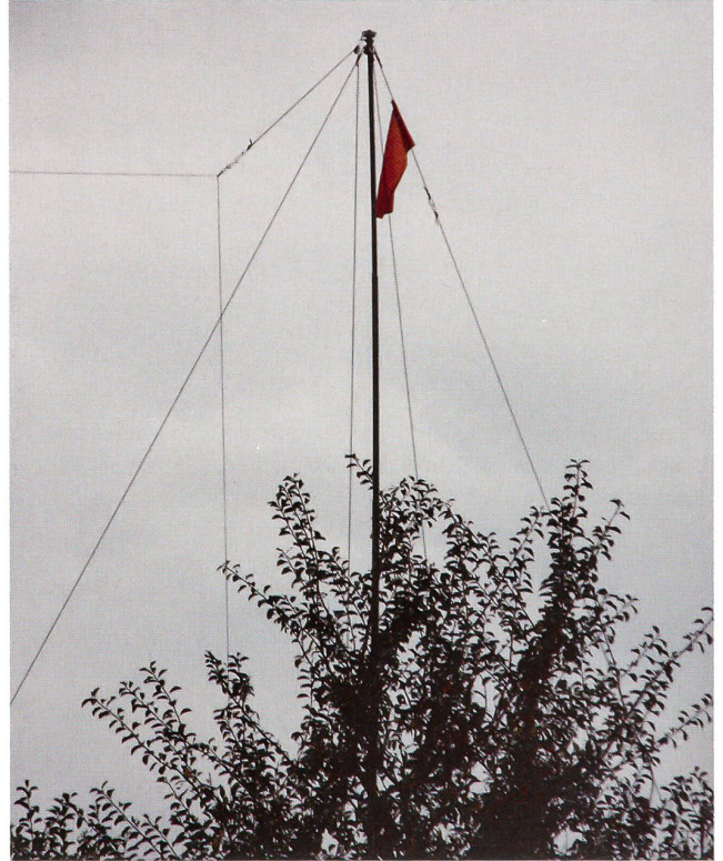
Die Breitband-Antenne BBA, gesichert durch das Fähnchen.
