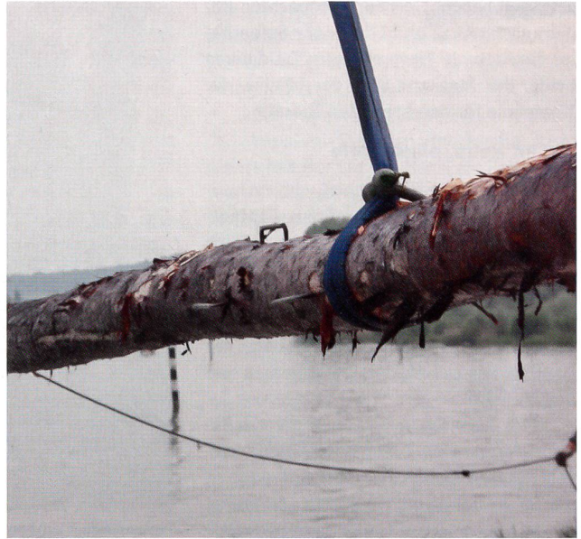
Beim maritimen Sealive-Zentrum fischt ein mächtiger Kran der Bundeswehr die ans Ufer gedrängten Stämme aus dem See.
