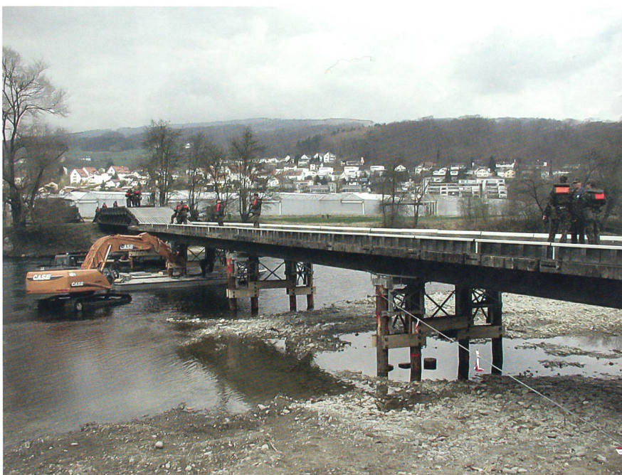
Stahlträgerbrücke (Eggenwil, Bremgarten AG).
