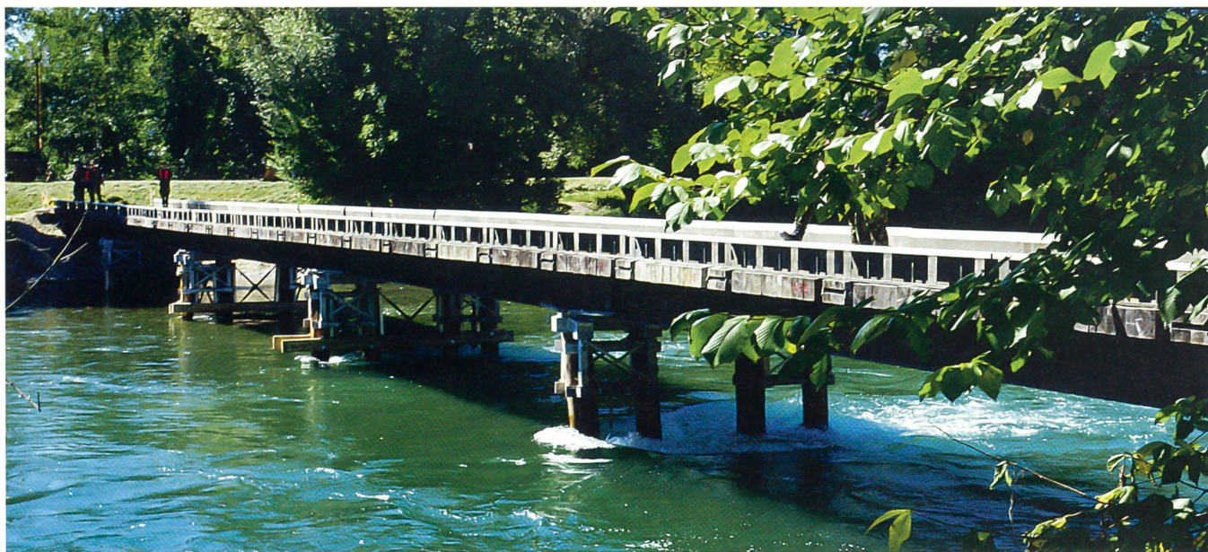
70 Meter lange Brücke über die Reuss bei Obfelden.
