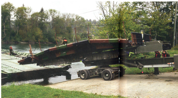
Die Rampe wird zur Fähre gebracht und dann verbunden.
