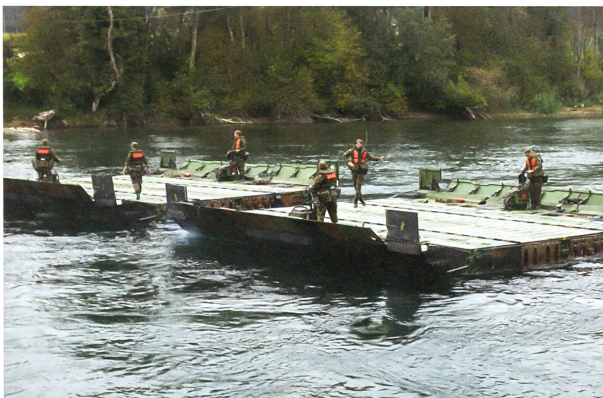
Rückbau der Fähre zu einzelnen Modulen.
