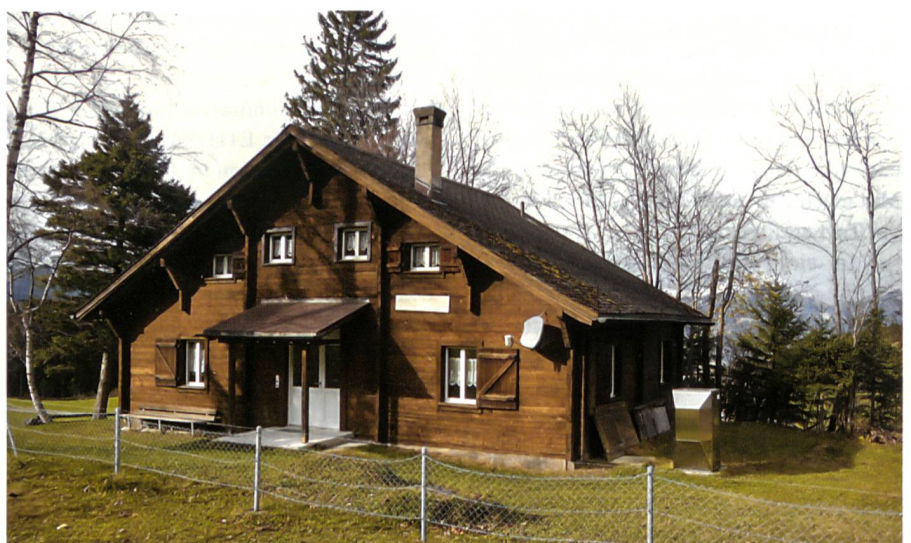
Das ehemalige Sende- und Unterkunftsgebäude. Im Untergeschoss befanden sich der Sender, ein schalldichtes Notstudio und zwei kleinere Hilfsräume.
