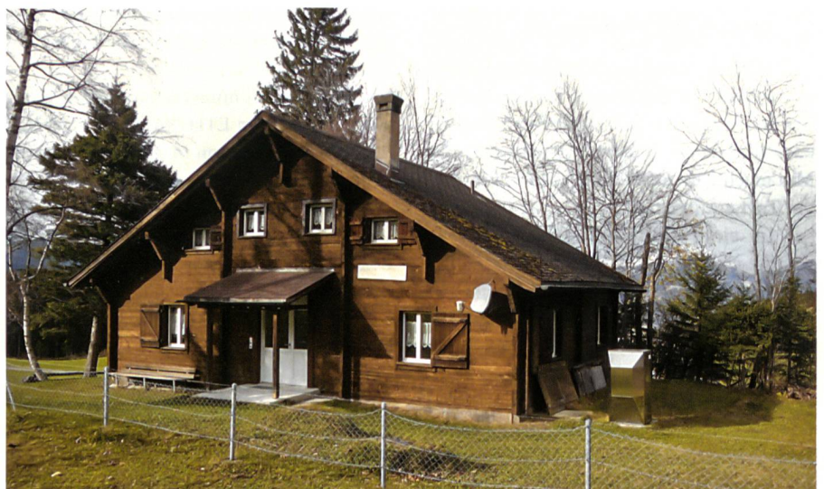
Das ehemalige Sende- und Unterkunftsgebäude. Im Untergeschoss befanden sich der Sender, ein schalldichtes Notstudio und zwei kleinere Hilfsräume.
