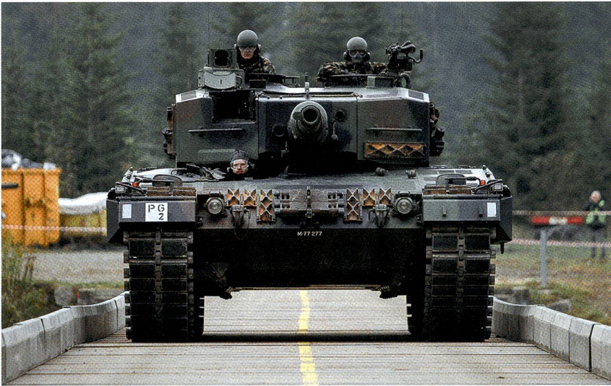
Ein 3,80 m breiter Kampfpanzer Leopard auf der 4 m breiten Stahlträgerbrücke.
