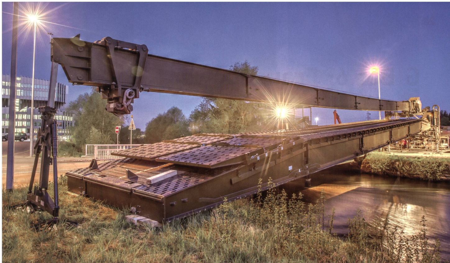
Die 36 Meter lange Unterstützungsbrücke über den Rootkanal.
