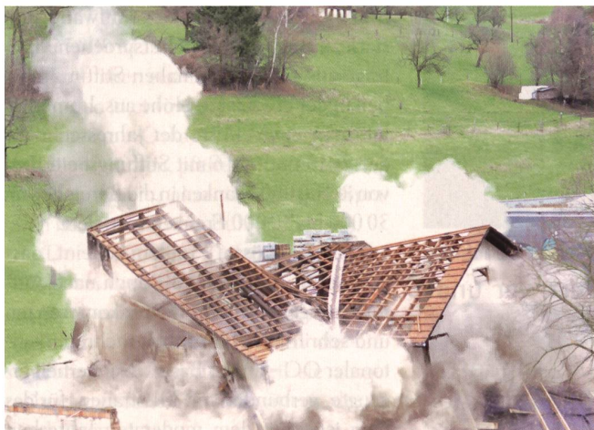
So verlief die gelungene Sprengung.
