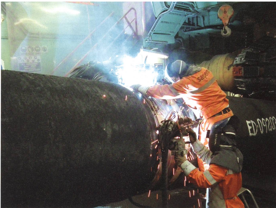
Arbeiter der italienischen Firma Saipem verschweissen Nord-Stream-Rohre.
