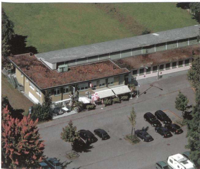
Die Anlage auf dem Hönnggerberg.
