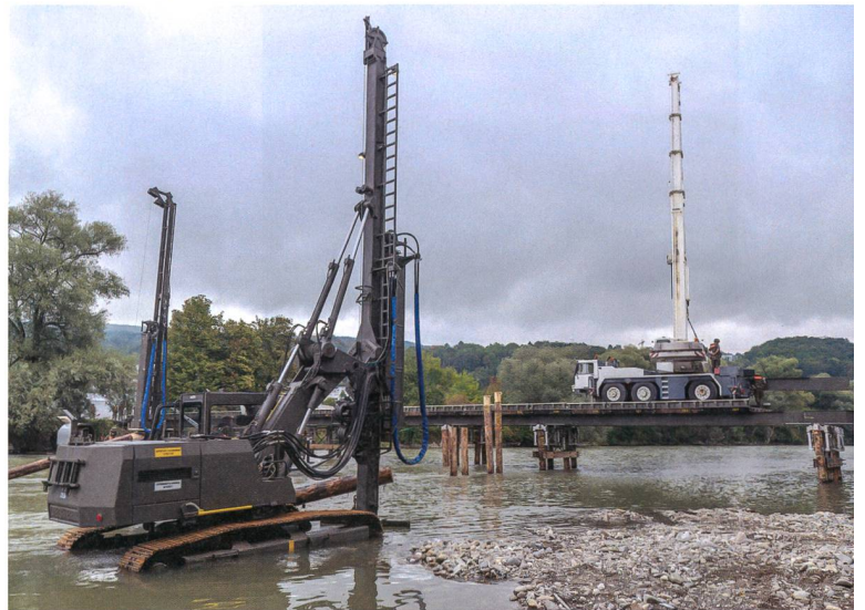
Mit Dieselramme werden die Brückenpfeiler eingesetzt.
