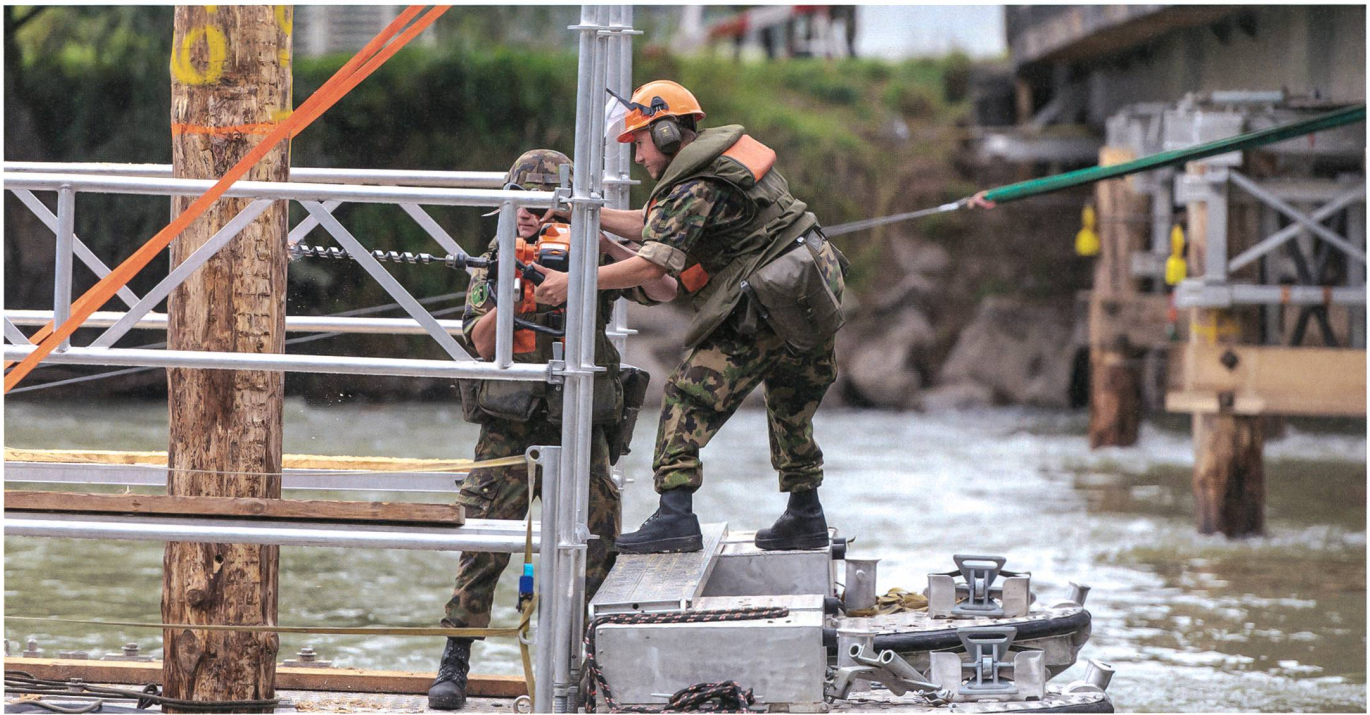
Rammpontoniere beim Bau von Brückenpfeilern.
