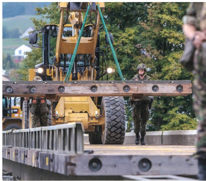
Sappeur beim Bau einer Stahlträgerbrücke.
