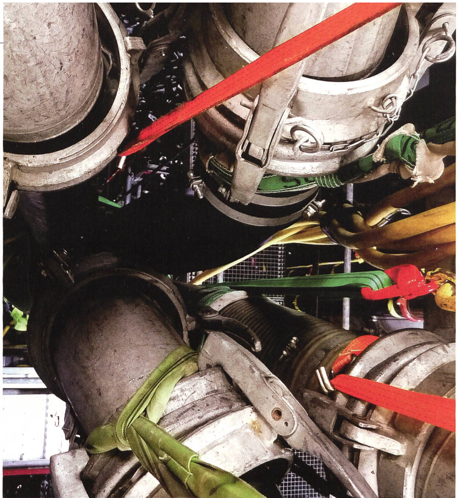
Die Pumpen hatten wir an einem Nachmittag installiert. Anschliessend gab es während ein paar Tagen noch einige Korrekturen zu erledigen. Danach stand immer ein kleines Team einsatzbereit. Die Tage und Wochen, die uns für diese Betreuung zur Verfügung standen, machten den Grossteil dieses Einsatzes aus.
