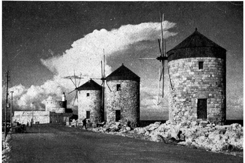
Windmühlen auf der Insel Rhodos. Sie pumpen das Grundwasser in die Bewässerungsgräben.
