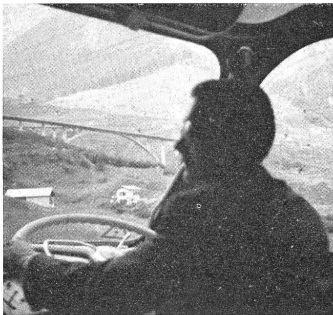
Im Hintergrund ein Viadukt an dem noch im Bau befindlichen Strassenstück auf der Südseite des San Bernardino.
