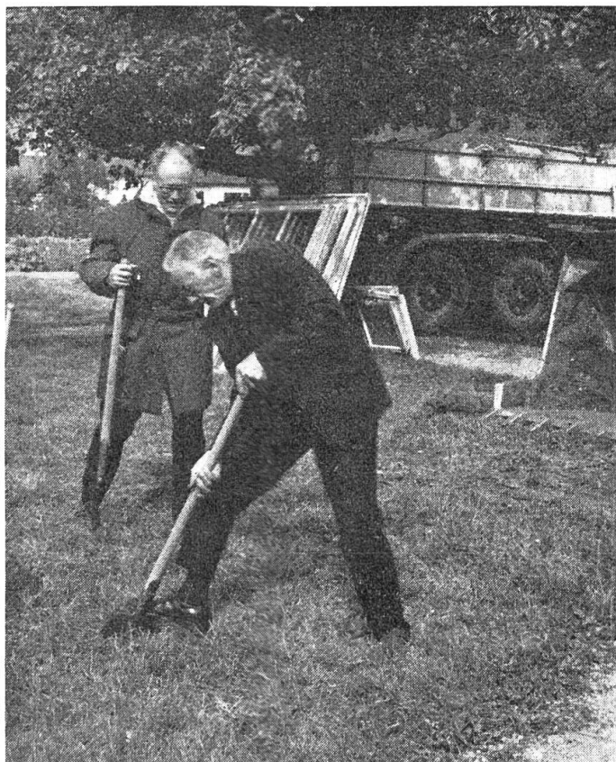
Gottfried Wäffler als Stellvertreter aller Pensionäre beim «ersten Spatenstich». Herr Wetter von der Engern Kommission macht sich auch zur Arbeit bereit. Auf dieser Wiese wird in Zukunft der «Küchentrakt» mit Küche, Speisesaal, Fernsehraum und Wohnzimmern stehen.
