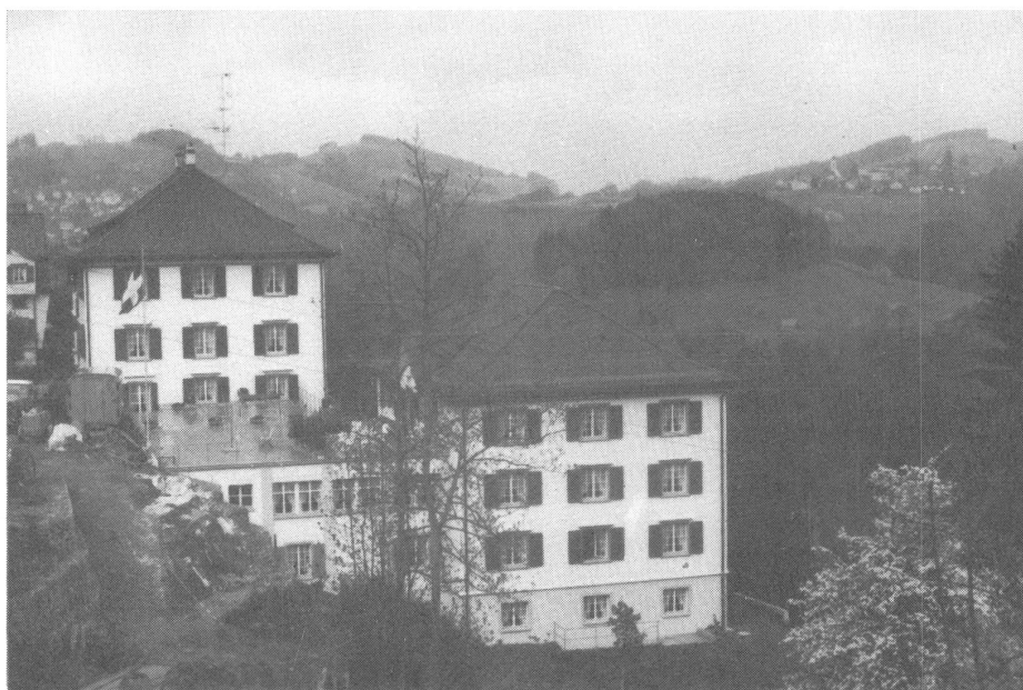
Gesamtansicht des Heimes, links der Altbau.
