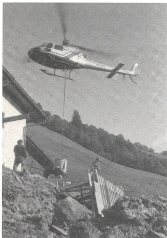
Helikoptereinsatz während der Umbauarbeiten!
