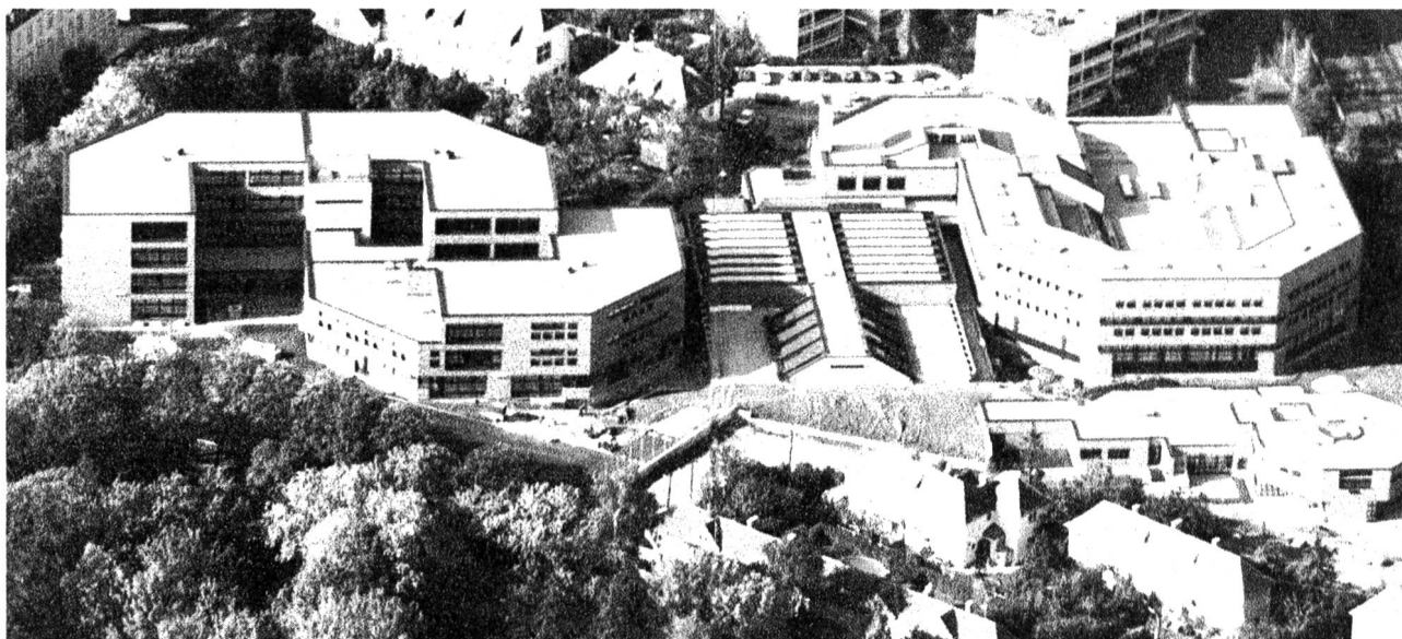
Das moderne Schulgebäude des BIG in Wien
