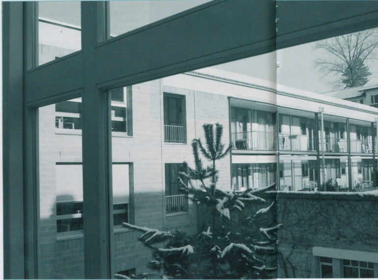
Das Betaglenzentrum Laupen: Heim, Tagesstätte und SpiteX unter einem Dach.
