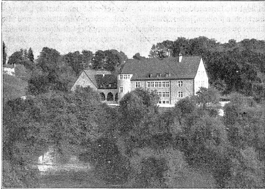
Schulhaus Augst, Baselland Ansicht vom Dorf her
