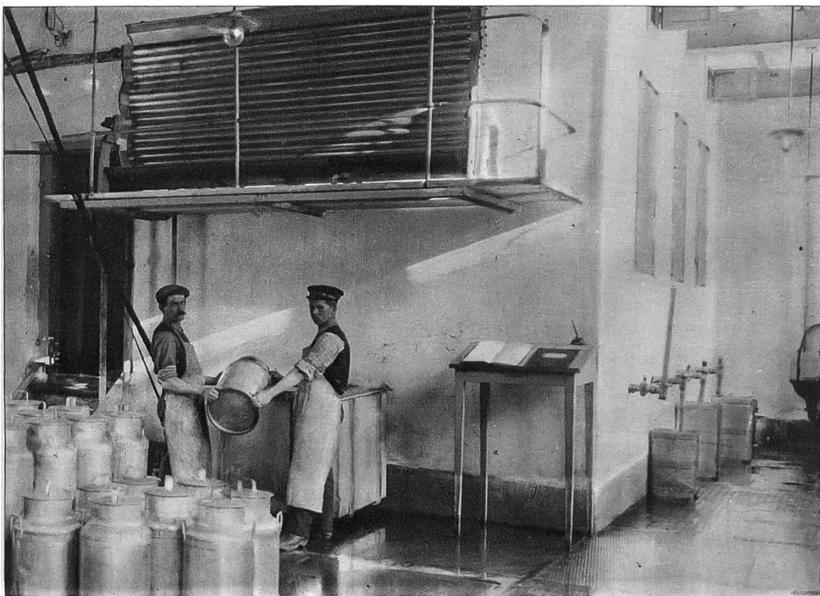
Filter-, Kühl- und Abfüllanlage der Konsum-Molkerei
