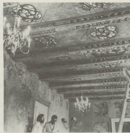
... et après rénovation
