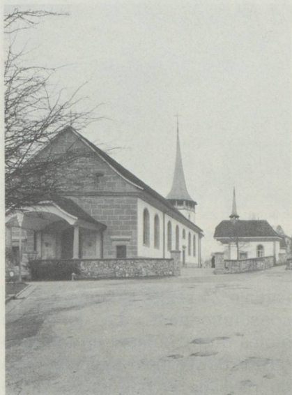
Rénovation de l'ancienne église à Tavel (FR)
