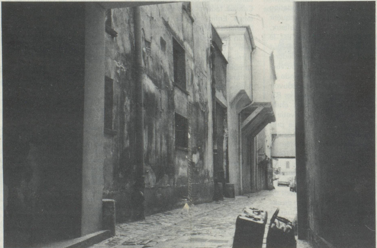
A l'arrière du bâtiment, dans la ruelle des Arbalétriers, l'entrepôt à transformer en salles (à gauche).
