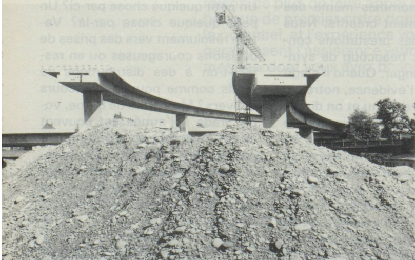
Les mêmes chances pour le rail et la route? Notre photo: autoroute en construction à Bâle.
