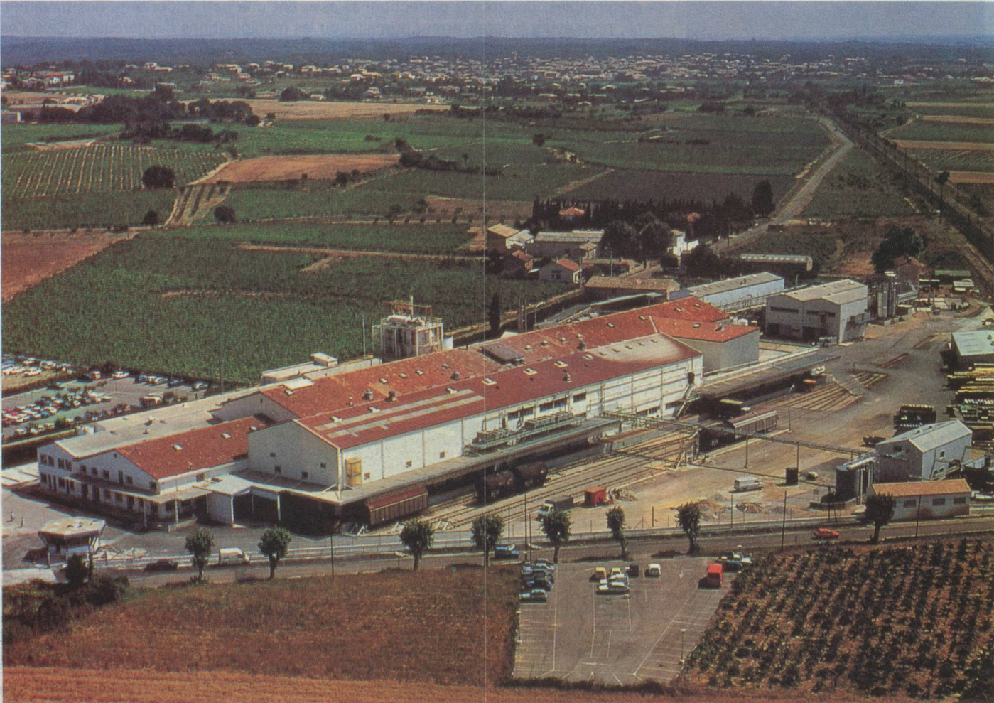
Vue aérienne de l'usine
