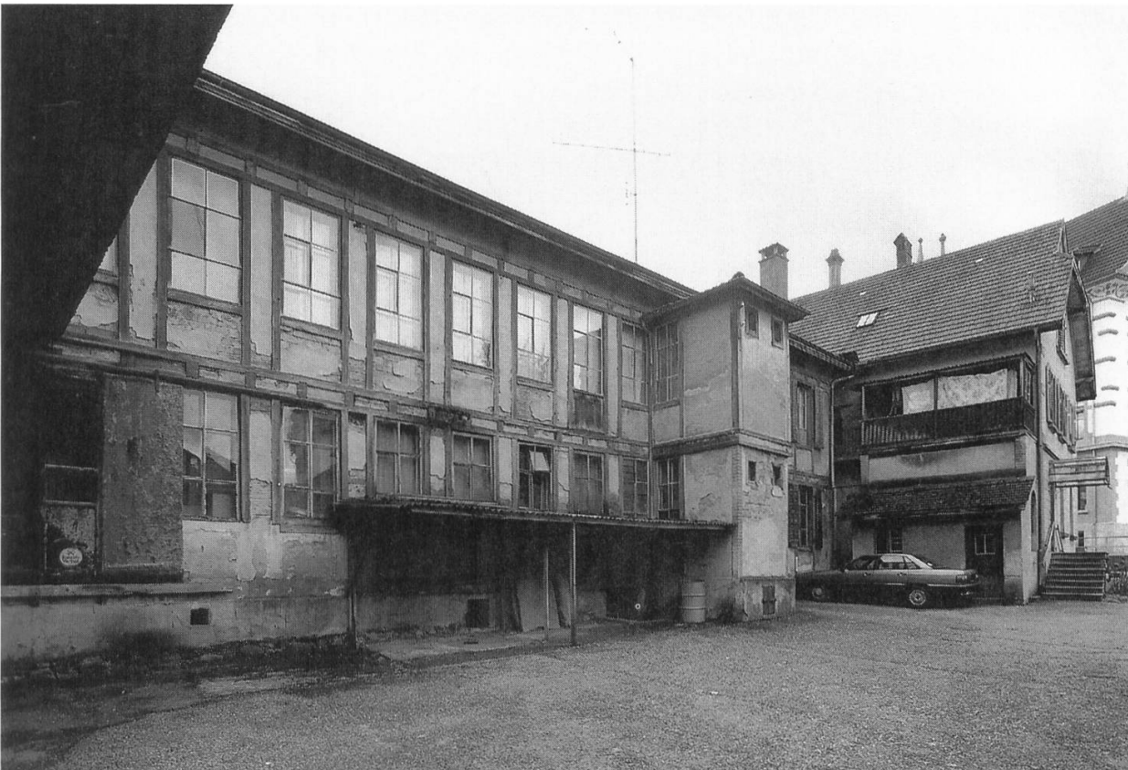
Vor dem Abbruch 2001 erinnerten die langen Fensterfronten des alten Gebäudes der Möbelfabrik Meier an der Sure daran, dass in seinen Räumen einst eine Uhrensteinfabrik untergebracht war.
