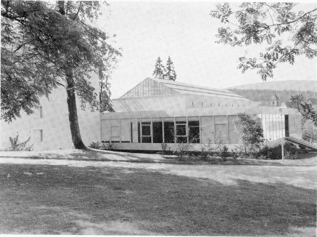
Blick aus dem Aarauer Rathausgarten auf den Gebäudekomplex von Kantonsbibliothek, und Kunsthaus, von welchem allerdings nur das große Glasdach sichtbar ist
