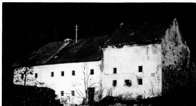
Steinmühle (mit Ruine : Hafermühle) Südansicht
