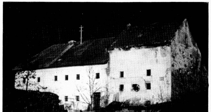
Steinmühle (mit Ruine : Hafermühle) Südansicht
