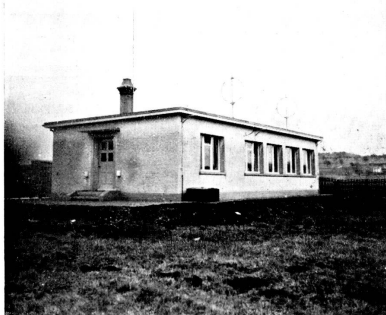
Aussenansicht der Verkehrskontrollstation Dübendorf.
