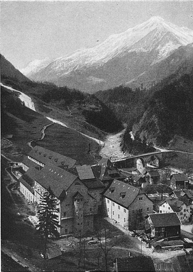
L'usine d'Amsteg / Das Kraftwerk Amsteg 90,000 chevaux 90,000 PS Phot. Ruffel, Zürich
