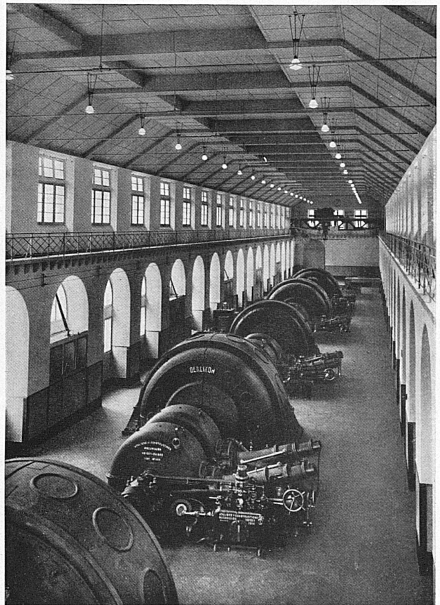
Usine d'Amsteg, Salle des machines / Maschinensaal des Kraftwerkes Amsteg
