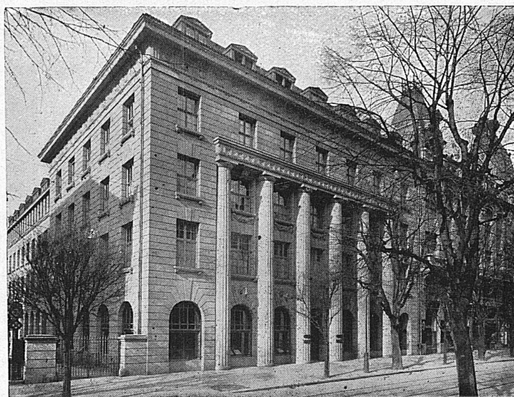
Verwaltungsgebäude des Geschäftssitzes Zürich Hôtel du siège de Zurich
