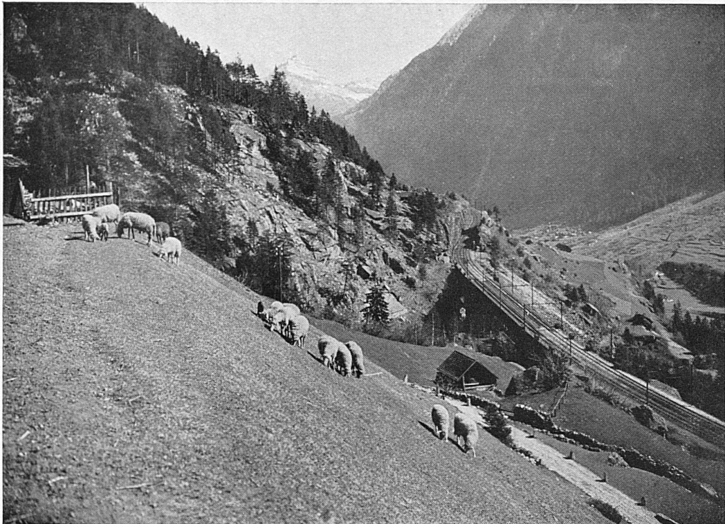
Das Reusstal hinauf / La ligne du Gothard dans la vallée de la Reuss Phot. Riffel, Zürich
