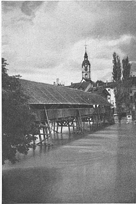
Alte Holzbrücke über die Aare in Olten Phot. Mischol
