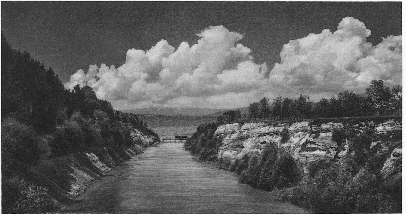
Am Aarekanal bei Hagneck / Le canal de l'Aar à Hagneck / The canalised Aare at Hagneck / Il canale dell' Aar presso Hagneck Phot. Gaberell
