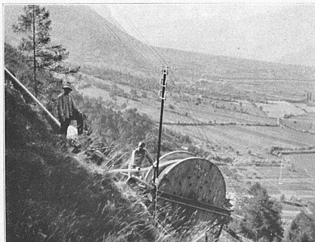
Pose en montagne de câbles à haute tension
