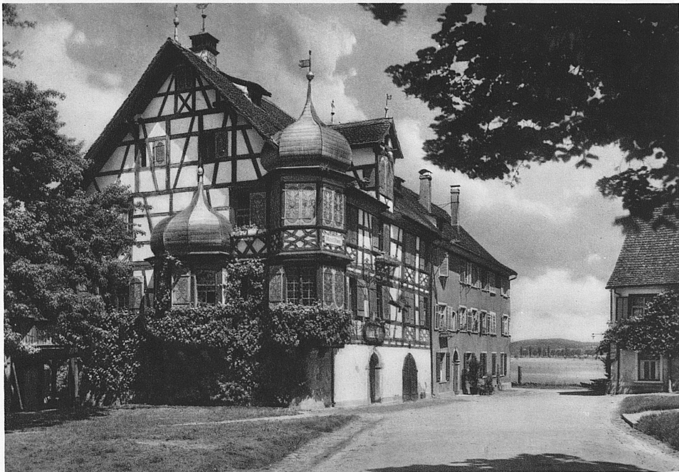
Haus zur Drachenburg bei Gottlieben am Bodensee / Le „Drachenburg“ près de Gottlieben sur le lac de Constance / A House on the Drachenburg, near Gottlieben, on the Lake of Constance / Casa „Drachenburg“ presso Gottlieben sul Lago di Costanza Phot. A. Steiner
