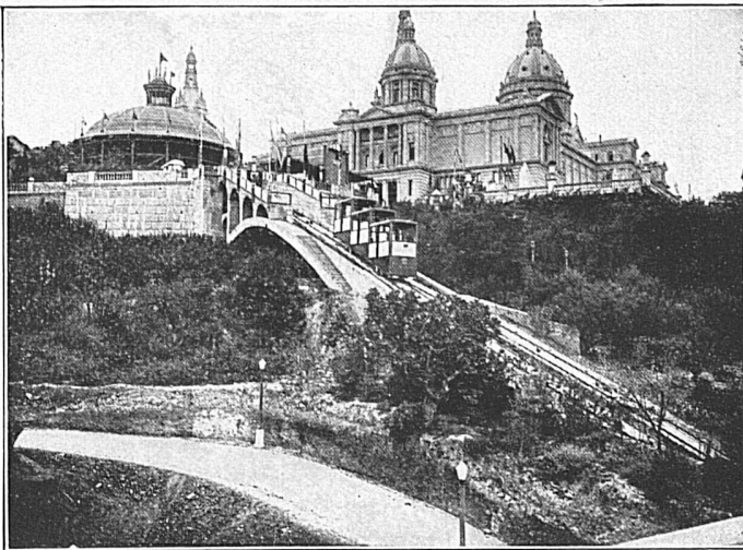
Drahtseilbahn beim Nationalpalast in der Internationalen Ausstellung in Barcelona, mit Wagen bis für 110 Personen
