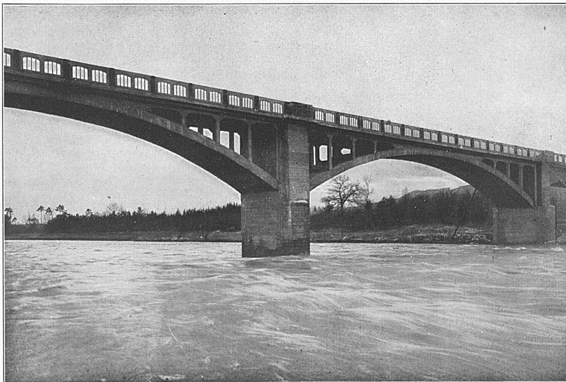
Strassenbrücke über die Thur bei Weinfelden
