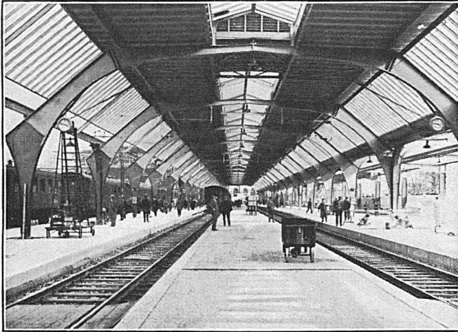
Umbau Hauptbahnhof Zürich, 1930; Perron-Längshalle 1, Total = 7 Hallen, welche nach unsern Berechnungen und Konstruktionsplänen ausgeführt werden
