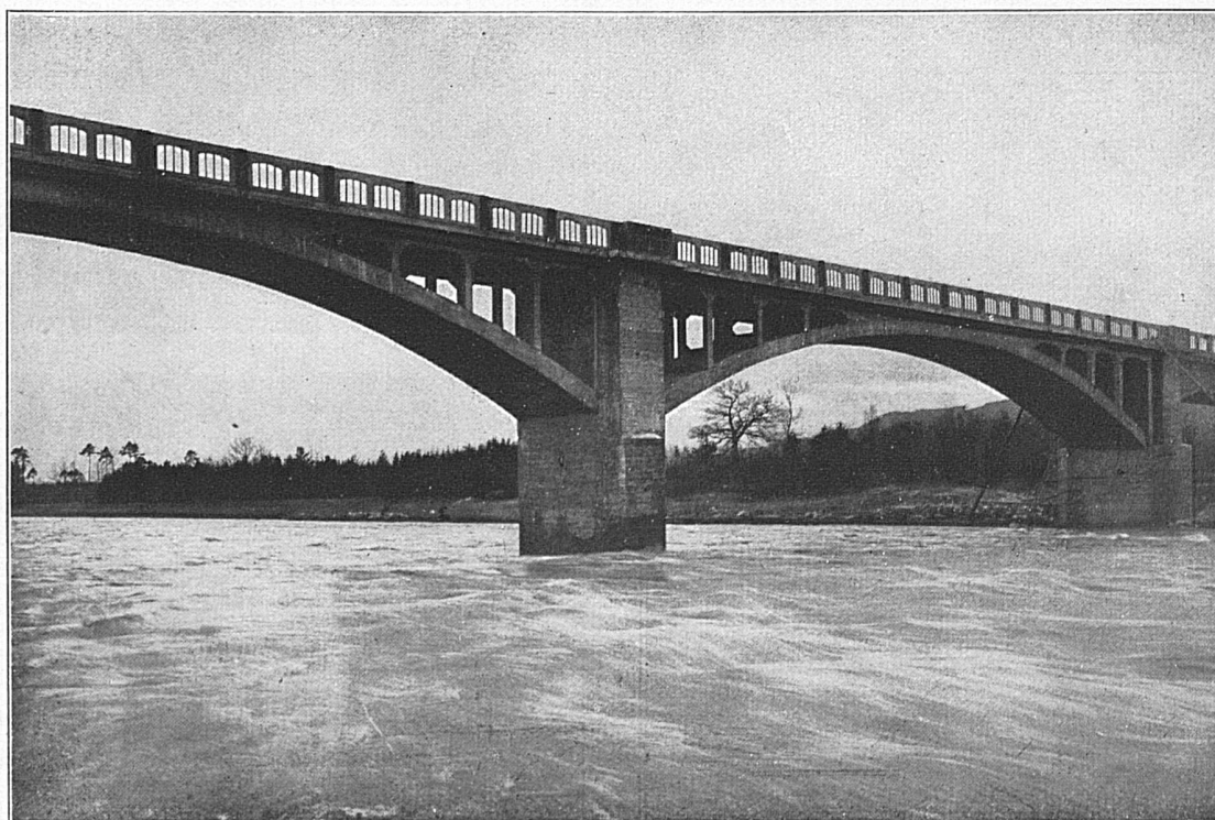
Strassenbrücke über die Thur bei Weinfelden
