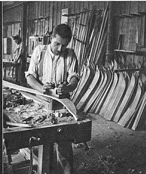
Feingefühl erfordert das Verputzen der Lauffläche
