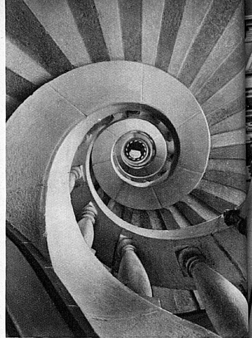
Der „Schneggen“, freitragende interessante Treppe im Rathaus
