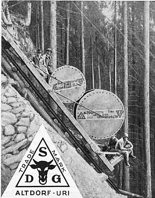
Verlegung der Bleikabel für KW-Sernf-Niedererenbach. Pose des câbles sous plomb pour la Centrale de Sernf-Niedererenbach
